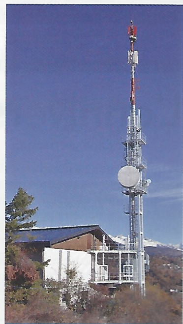
Bâtiment et antenne Swissscom.
